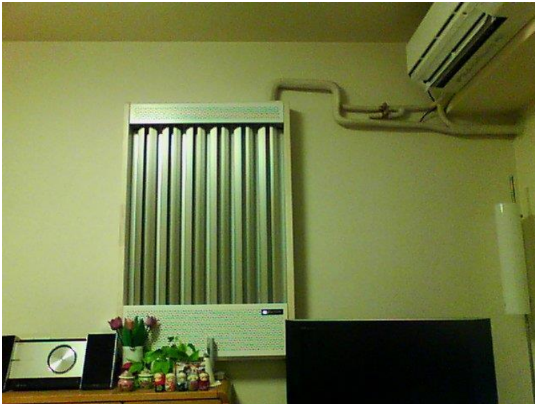
輻射パネル設置状況
