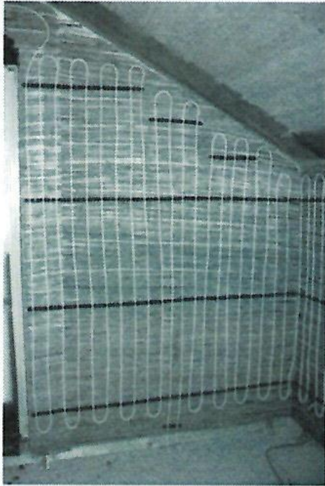
図21 ポリプロピレン管を塗り下地材であるアシボードに留めた壁暖房 (配管は土モルタル、石灰モルタルなどで塗りこむ)
