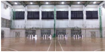
エアコン室内機と SCREEN パネルが上下にセットで、まとめて設置されている
