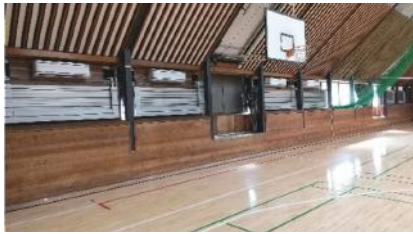
図4 立川女子高等学校体育館の機器設置状況
