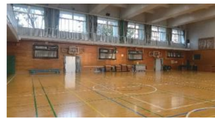
エアコン室内機とLOWBOYパネルが上下に一体的に設置されている
