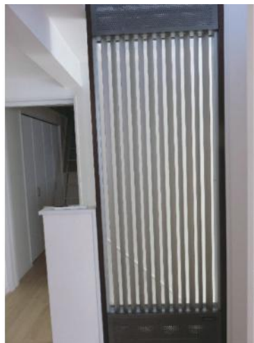
写真4 2階パネル設置状況
