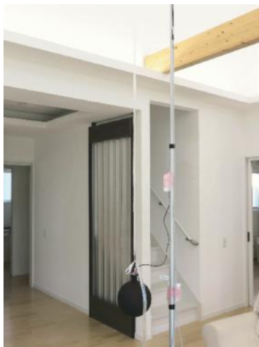
写真3 1階パネル設置状況
